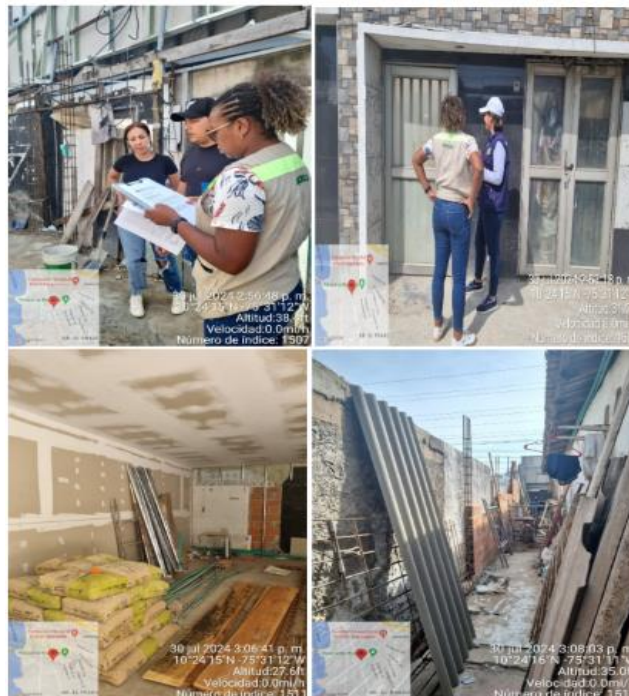
Ilustración 2. A) realización de visita técnica b) actividades de reparaciones locativas. Fuente: EPA, 2024. Por otra parte, se pudo constatar que, el establecimiento comercial cuenta con renovación de Pin generador 1-1185-001-1 expedido el 12 de julio de 2024.
