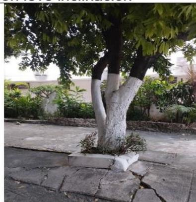
**Imagen 5. Agrietamiento del piso por las raíces del árbol oití**
