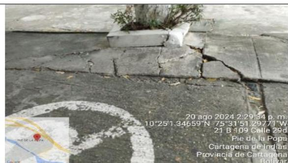
**Imagen 2. Agrietamiento del piso por las raíces del árbol**
