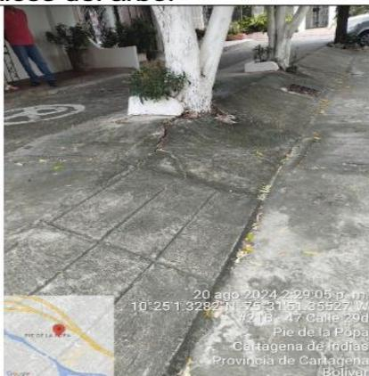
**Imagen 4. Agrietamiento del piso por las raíces del árbol Oití**
