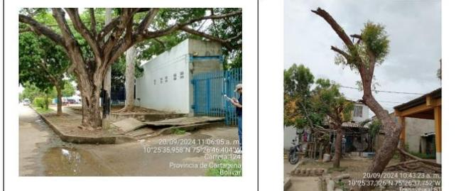
**Imagen 6. Campano inclinado, daño estructural y pudrición, ubicado frente CDI 2 TALA DE EMERGENCIA. TALA DE EMERGENCIA.**
