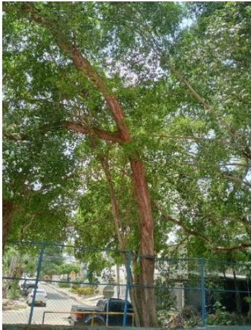
Imagen 5. Gallinero inclinado, con ramas extendidas sobre lampara. Poda de formación y reducción de altura
