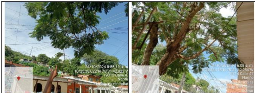
Imagen 4. Ramas en contacto con redes eléctricas sin encauchar de media tensión
