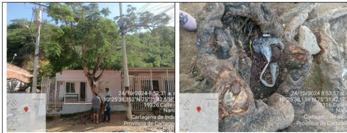
Imagen 2. Panorámica ubicación árbol Acacia roja entre transformador y poste de energía eléctrica.
