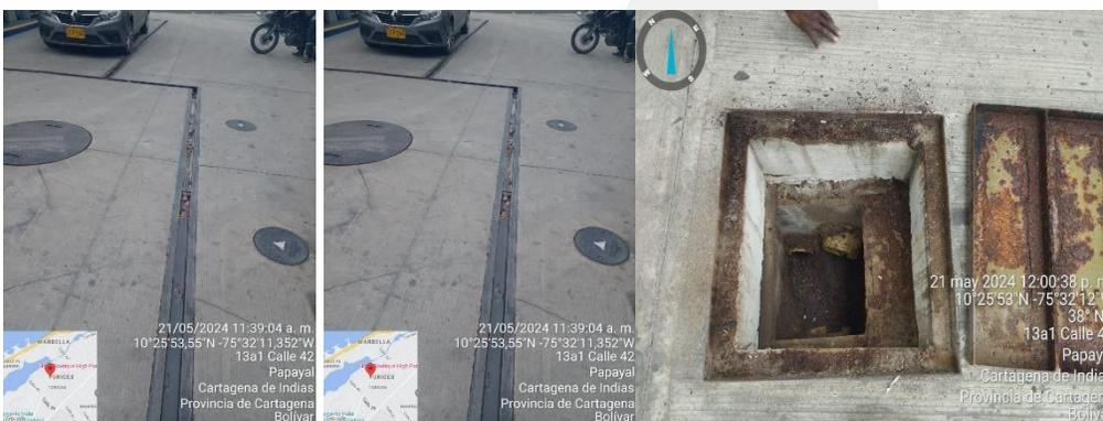
Figura 4. (a) Rejillas perimetrales. (b) y (c) Sistema de trampas de grasas y sedimentadores. - EDS LA PALENQUERA Fuente: Autores, 2024.
