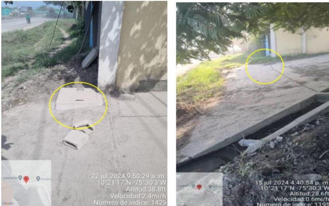
*Ilustración 7. Registro que colecta las aguas residuales domésticas y aguas lluvias.*
