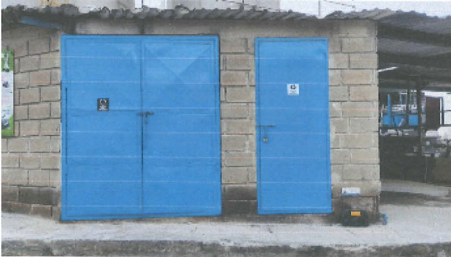
Fotografía N° 1: Vista externa depósito de residuos aprovechables y no aprovechables
