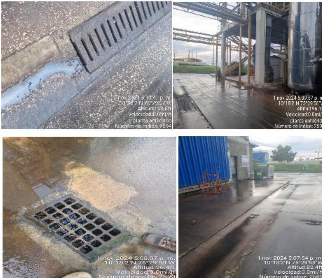
Figura 5. Sistema de trampas ubicadas en la planta de Anhídrido Ftálico
