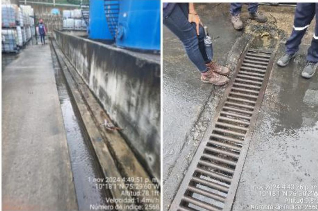
Figura 6. Sistema de trampas en la zona de almacenamiento
