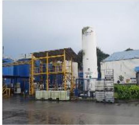
El sitio de almacenamiento de residuos peligrosos no cuenta con dique de contención, no se encuentra cerrado lo que permite el ingreso de vectores, aguas lluvias, se observó láminas rotas en el techo y los residuos almacenados no estaban identificados.
