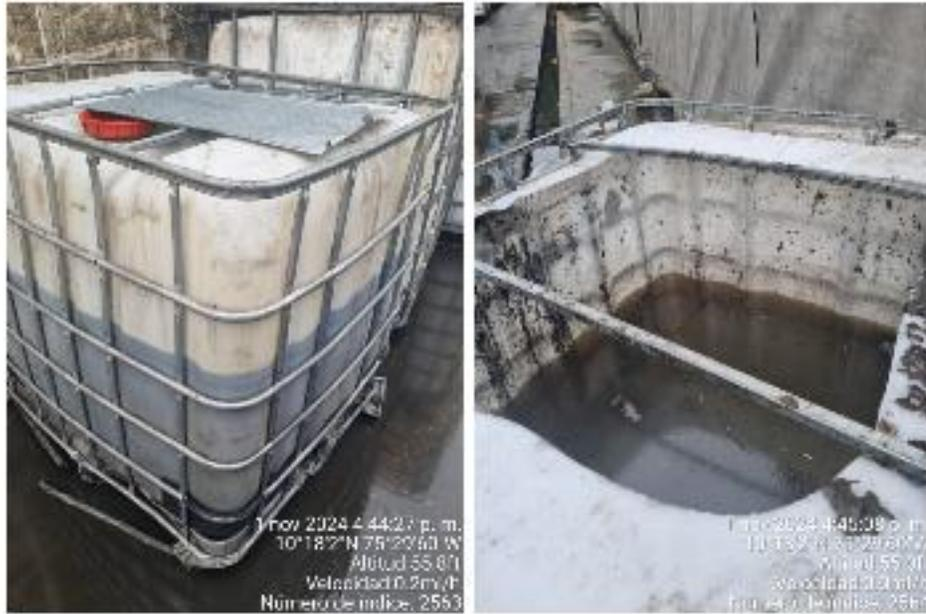
Figura 8. Almacenamiento inadecuado de ARnD en tanques IBC.
