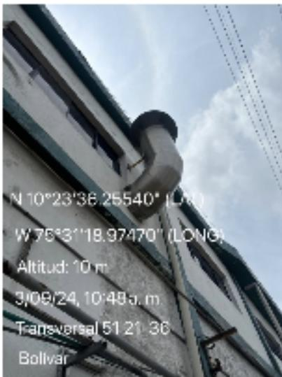
*Fuente fija de planta eléctrica: En las instalaciones se encuentra ubicada una planta eléctrica de modelo EDI-500-CB, Serie YM397037, Marca Energy Dynamics, caballos: 750, RPM 1800, CPL 1170 Modelo de motor KTTA1962, serie: 37145129, la cual contiene una fuente fija que emite una vez se suspende el fluido eléctrico en la planta, es decir solo se usa como contingencia;*
