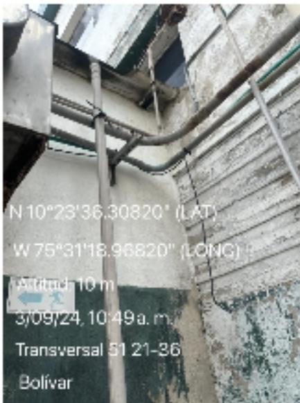
**Fuente fija de extractor de lavado:** se cuenta con un extractor en la zona de lavado de moldes que permite evacuar el aire hacia el exterior, evitando así la condensación que produce humedad. A continuación, se muestra imagen;
