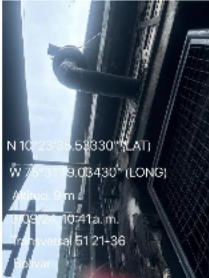
**Fuente fija de purga condensado:** se cuenta con una purga de vapor de medida altura 4mt y 2pulg, por lo que es necesario corregir y direccionar a la instalación adecuada.
