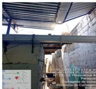
Siendo el 13/02/2025 a las 7:30am se realizó nuevamente visita a la empresa observándose la altura de la chimenea la cual, no cumple con la altura mínima de la chimenea o ducto debe ser por lo menos 3 metros (m) superior a la altura del edificio que contiene el ducto o
