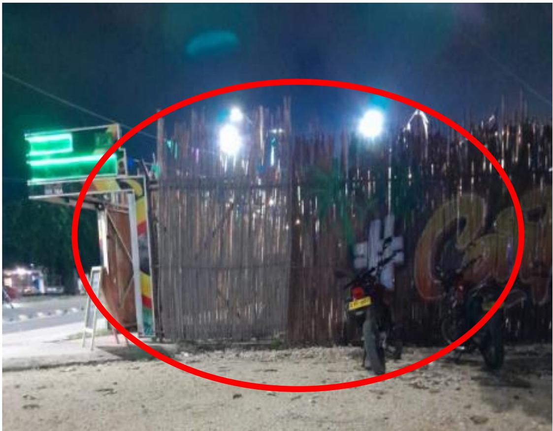
**Ilustración 1. No cuenta con sistemas de control y mitigación de ruido sus paredes son construida con varas de caña brava.**
