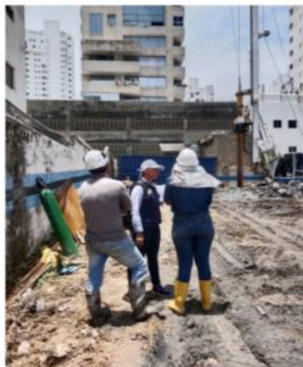
Ilustración 3. Vista de inspección
