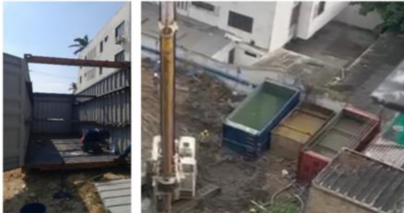
Ilustración 4. Tanques de almacenamiento temporal de aguas provenientes del nivel freático durante la perforación
