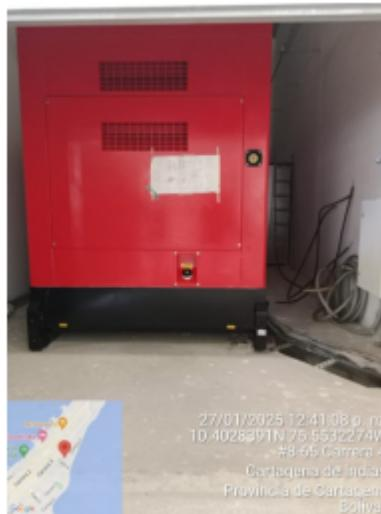
*La motobomba y la planta eléctrica están ubicada en cabinas cada una, lo que se pudo observar es que una de las medidas de contención; puerta se encontraba averiada o dañada lo que evita la contención o barrera para transferir el ruido al exterior, en caso concreto tiene el potencial de generar ondas sonoras al lado del edificio bahía.*
