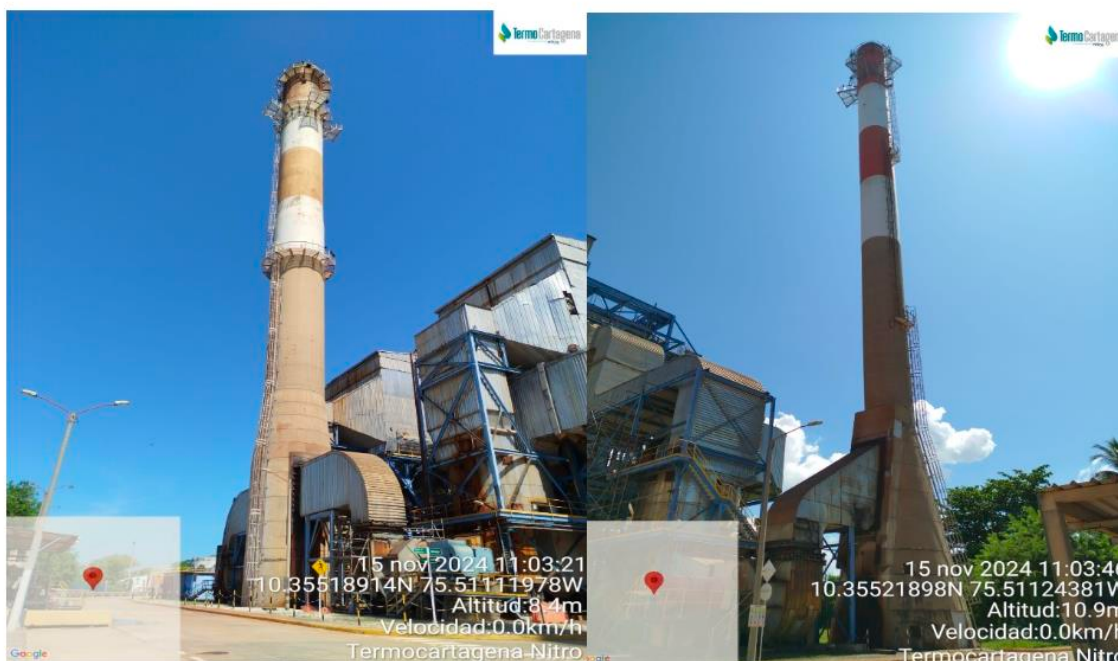
Chimenea de la unidad I y II
