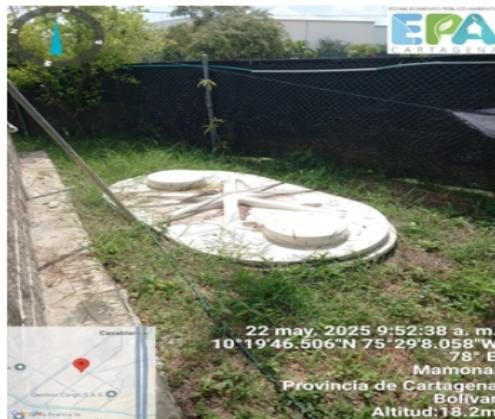
Figura 3. Tanque séptico para la disposición de sus aguas residuales domésticas
