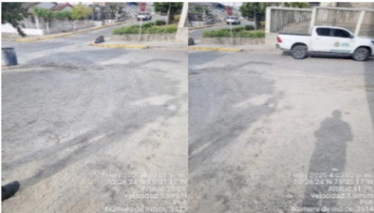
Ilustración 6. Acumulación de material en la entrada y salida de la obra
