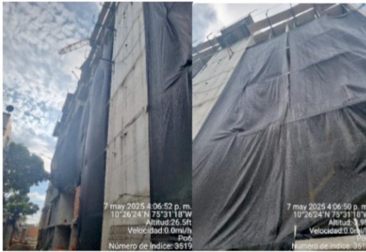
Ilustración 5. Instalación de malla protectora para evitar dispersión de material
