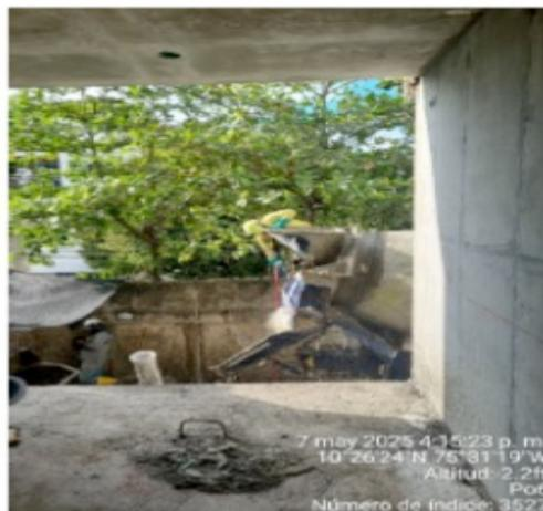
Ilustración 7. Lavado de mixer al interior de obra sin contar con sistema de pretratamiento y drenaje de las aguas hacia un sitio adecuado y autorizado.
