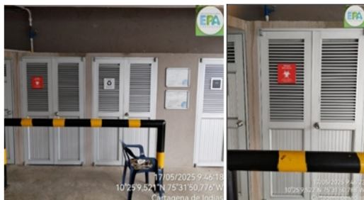
foto 3. Lugar de almacenamiento de residuos (RESPEL)
