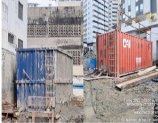
Ilustración 5. Tanques de almacenamiento temporal de aguas provenientes del nivel freático durante la perforación
