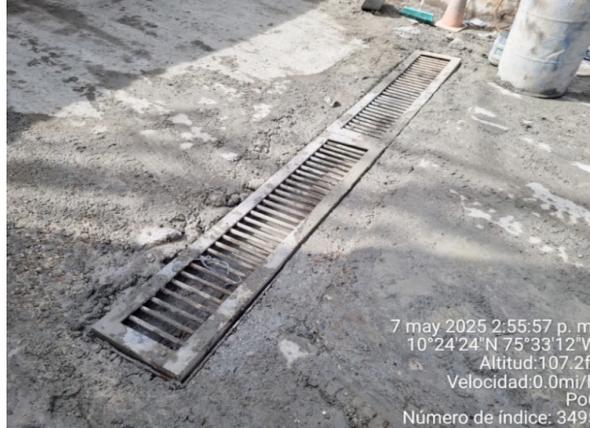
Ilustración 7. Canaleta con rejillas para retención de sólidos.
