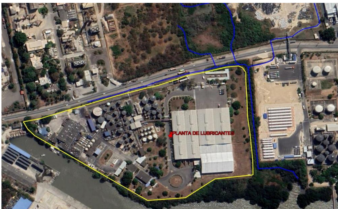
Figura 13. Drenajes áreas de obras de ocupación de cauce
