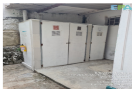
Foto 3. Puerta de almacenamiento residuos RESPEL
