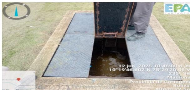
Figura 3. Tanque de almacenamiento de aguas domesticas
