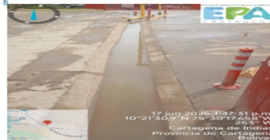
Figura 12. Canal perimetral Plataforma lavado
