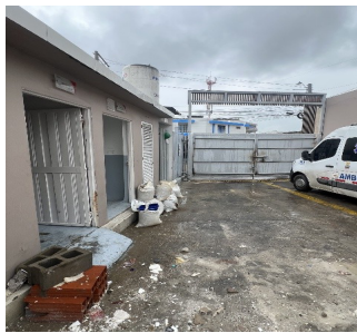
Foto 5. Ruta de evacuación
