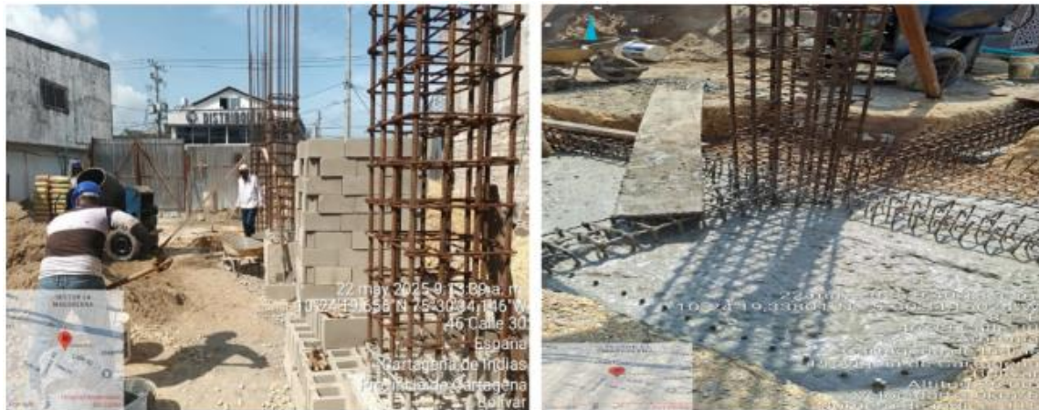
Ilustración 3: fundición para relleno de zapatas, pedestal y muros de contención. Fuente: Autor
