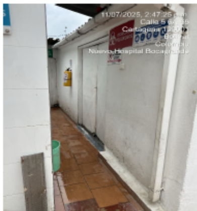
foto 6. Ruta de Evacuación
