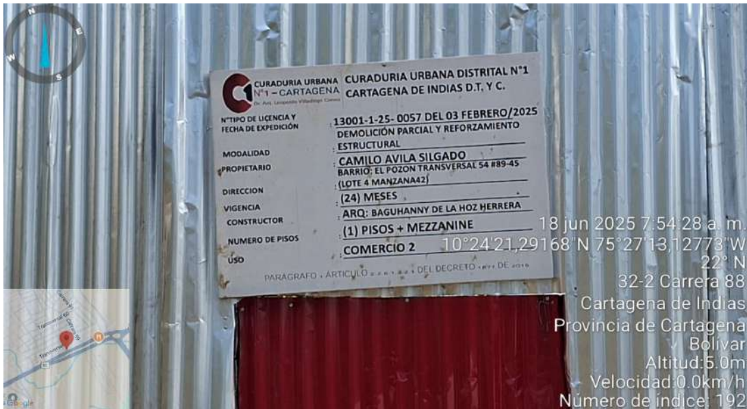
Ilustración 2: Valla informativa del proyecto. Fuente: Autores.
