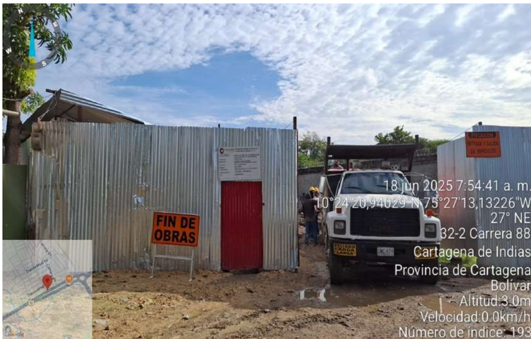
Ilustración 3: encerramiento de la obra comercializadora agrohierros S.A... Fuente: Autores.
