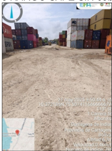
Figura 6. Suelo del parqueadero KARGO SAFE SIN cobertura en pavimento
