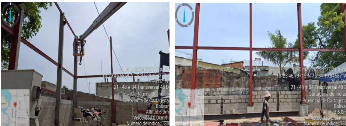
Ilustración 3 montaje de estructuras metálicas y levantes de muros.: Fuente: Autores.
