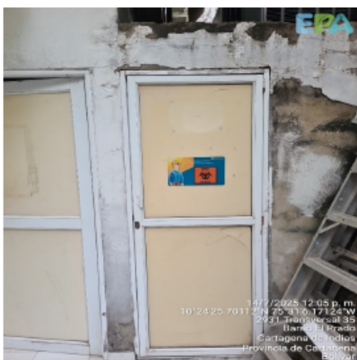
Foto 2. Puerta de almacenamiento residuos RESPEL
