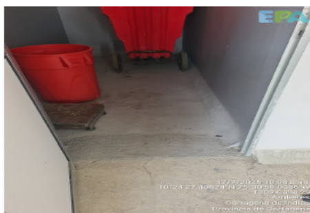
Foto 5. Dique Residuos RESPEL
