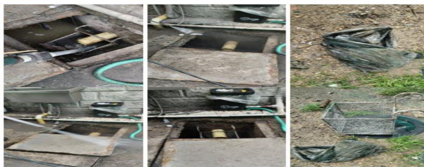
Figuras 5, 6, 7, 8, 9, 10. Mantenimiento de la poza séptica. Fuente: DNA FOODS S.A.
