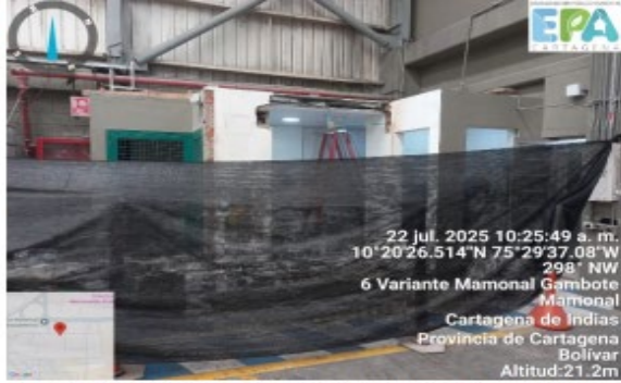
Figura 7. Centro de acopio principal en adecuaciones
