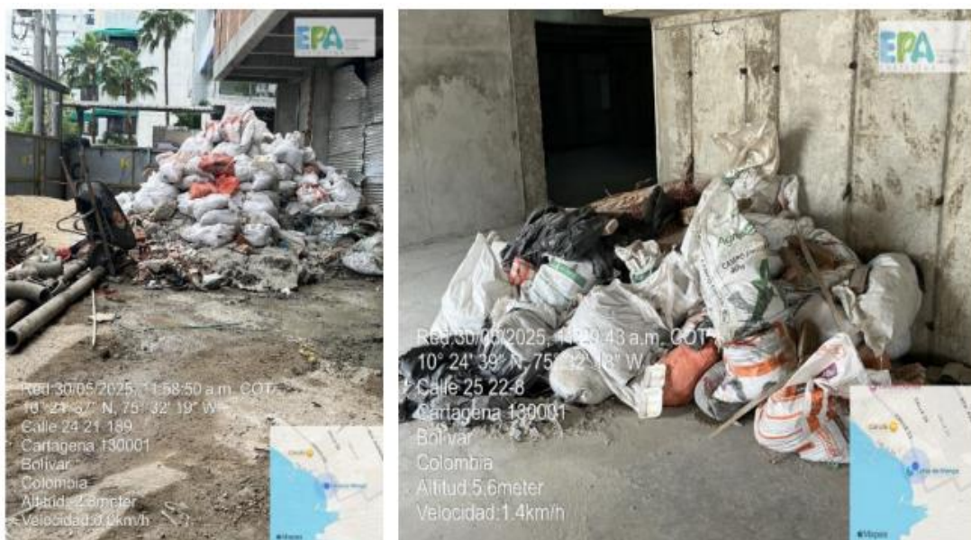
Figura 3. Acopio temporal de los RCD y residuos ordinarios generados en obra. Fuente: Autores, 2025.
