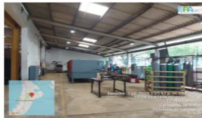
Figura 8. Área de soldadura.
