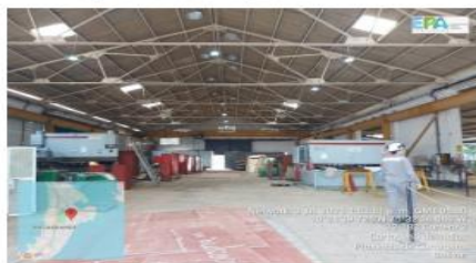
Figura 9. División de soldadura
