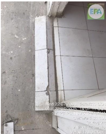
foto 7. Muro que impide vertimiento de sustancias hacia el exterior
