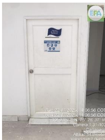
foto 3. Puerta rotulada de Almacenamiento
