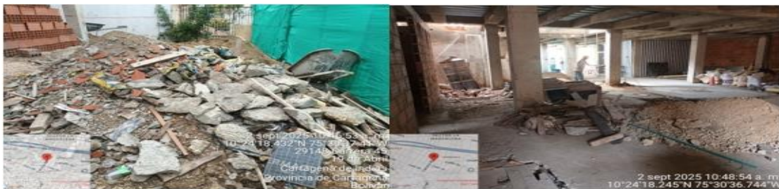
Ilustración 4: Material de excavación y demolición de columna y escalera de RCD en la obra. Fuente: Autores.
