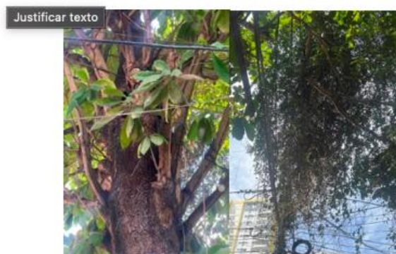
Imagen 4: Afectación por comején y planta parasita pajarita Fuente: Técnico Contratista
