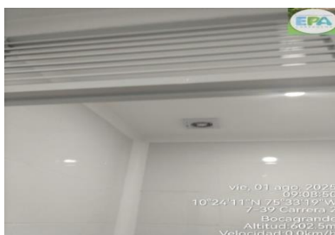
Foto 8. Cuarto iluminado con ventilación.
