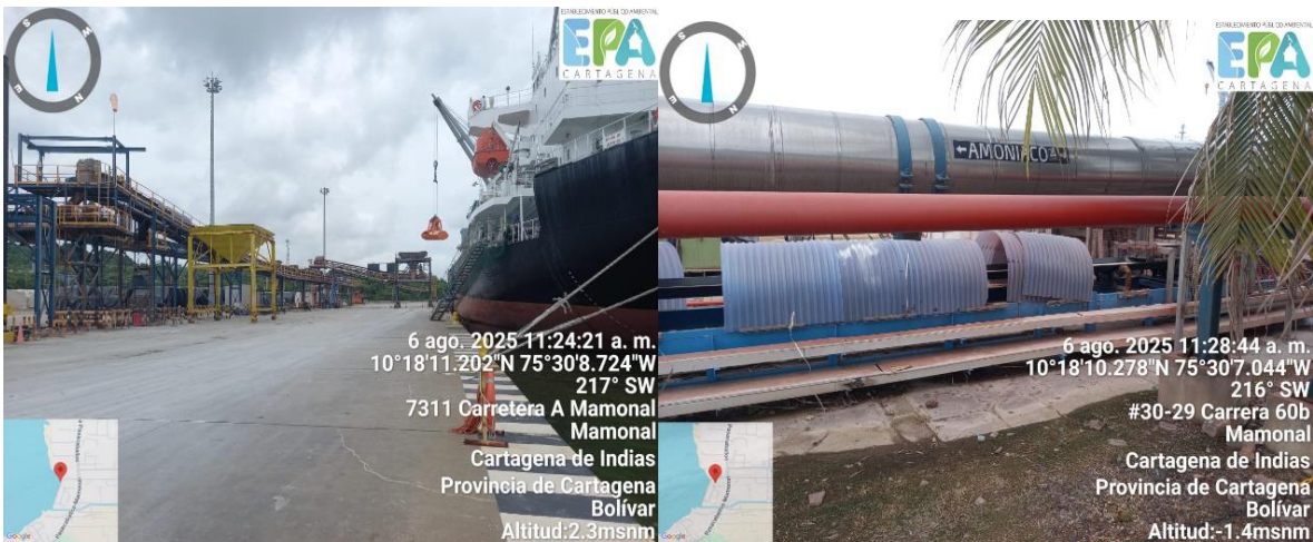
Figuras 4 y 5. Proceso de descargue del producto en la tolva; banda transportadora y tubería para el amoníaco, propiedad de YARA COLOMBIA S.A.S.
