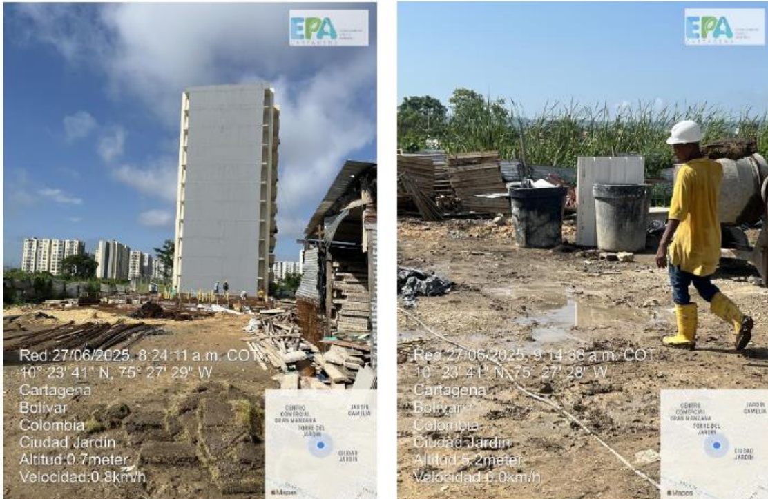
Figura 2. os de acopio en el proyecto EDIFICIO MAGNOLIA. Fuente: Autores, 2025.
