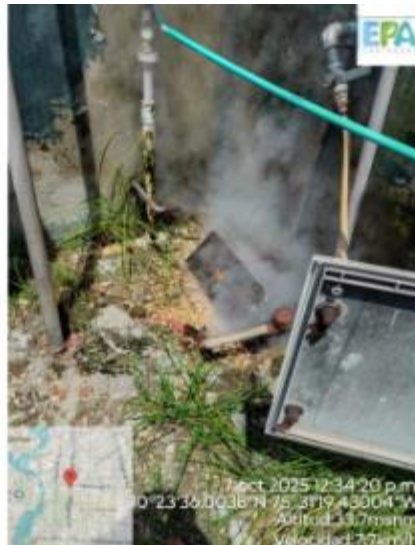
Figura 7. Ruptura de tubería que transporta vapor de las calderas
