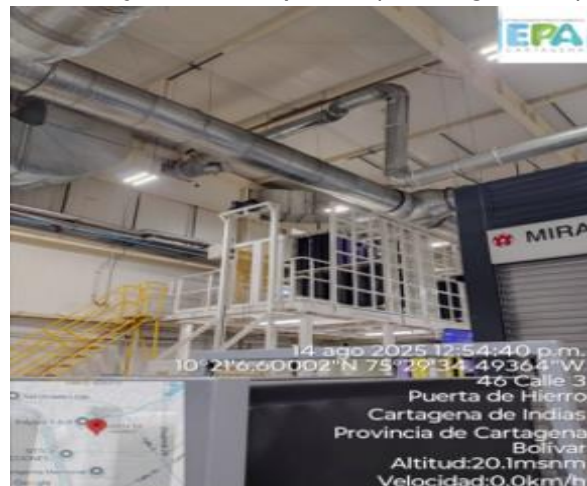
Figura 17. unión de ductos de salida de impresoras que conforman la fuente fija.
