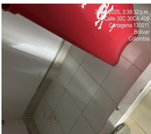
Foto 8. Dique de contención.
