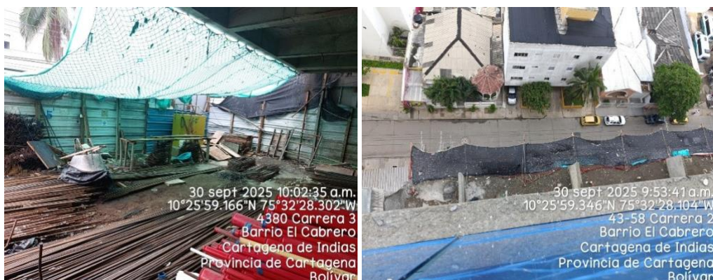
Figura 3. Protección perimetral del proyecto. Fuente: Autores, 2025.
