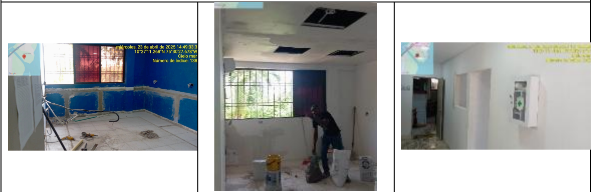
AVANCES EN LA ADECUACIÓN DEL LABORATORIO
