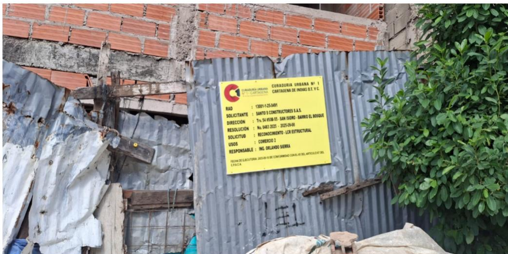
Ilustración 2: Valla informativa del proyecto. Fuente: Autores.
