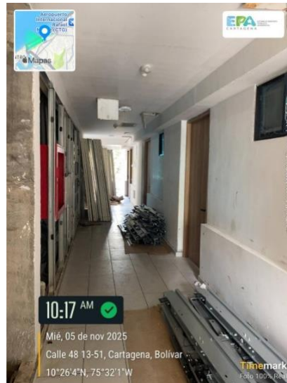
Figura 4. Desarrollo de acabados en los apartamentos del proyecto. Fuente: Autores, 2025.
