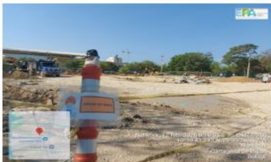
Figura 3. Parqueadero en proceso de pavimentación
