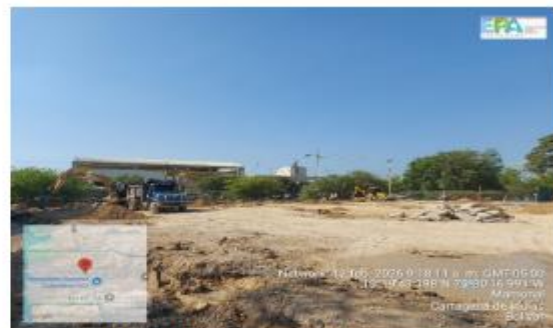
Figura 4. Parqueadero en proceso de pavimentación
