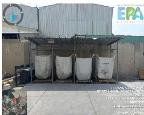
Figura 5. Centro de acopio de residuos no peligrosos
